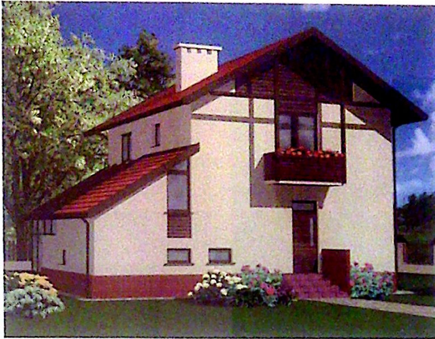
➔ 2 „Demokratka”. Tani, energooszczędny dom dla czteroosobowej rodziny. W elewacji widoczny podział na elementy stałe i zmienne: murowane otynkowane ściany nośne kontrastują z fragmentami elewacji wykonanymi w lekkiej szkieletowej konstrukcji wypełnionej drewnem. W wersjach wolno stojącej, bliźniaczej i szeregowej projekt został zrealizowany w kilku osiedlach
